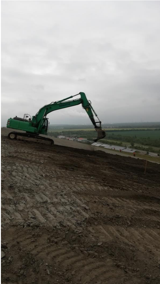
Abbildung 3: Einbau Rekultivierungsmaterial auf dem Deponiekörper
