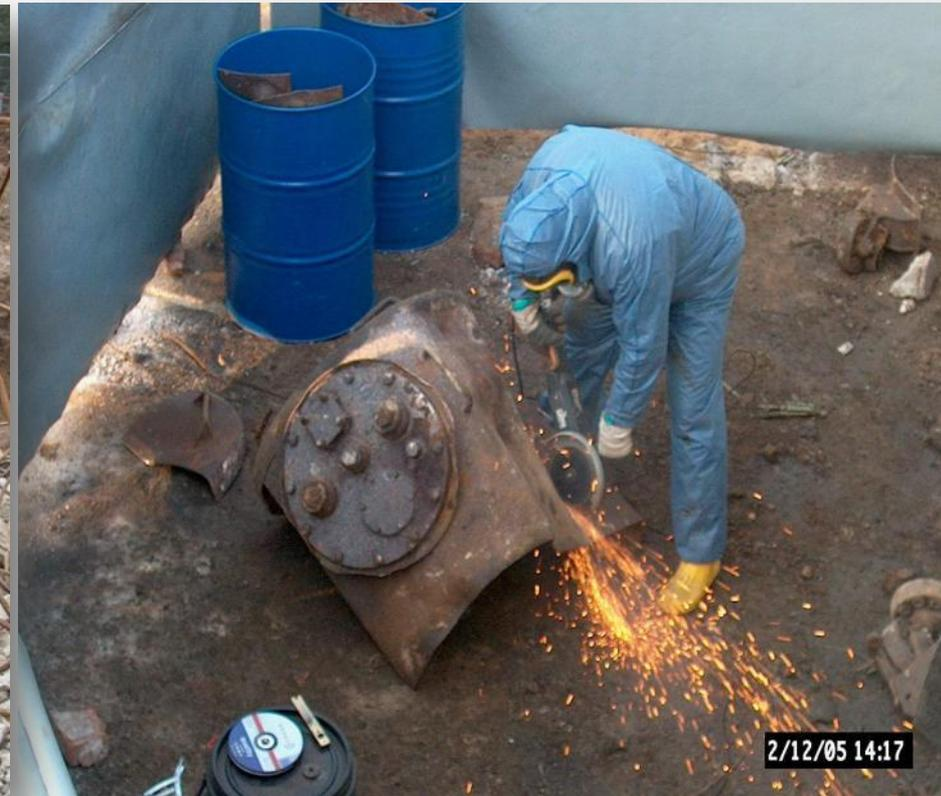
Bergung ,Zerlegung eines mobilen LOST-Behälters aus Bunkeranlage, MUNA Kapen
