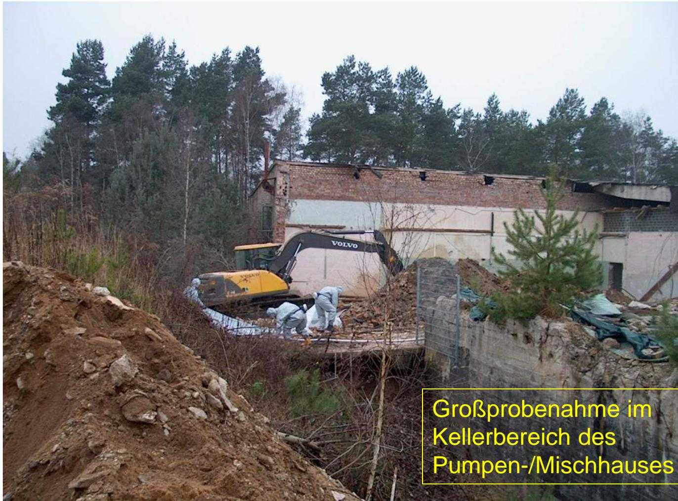
Großprobenahme im Kellerbereich des Pumpen-/Mischhauses
