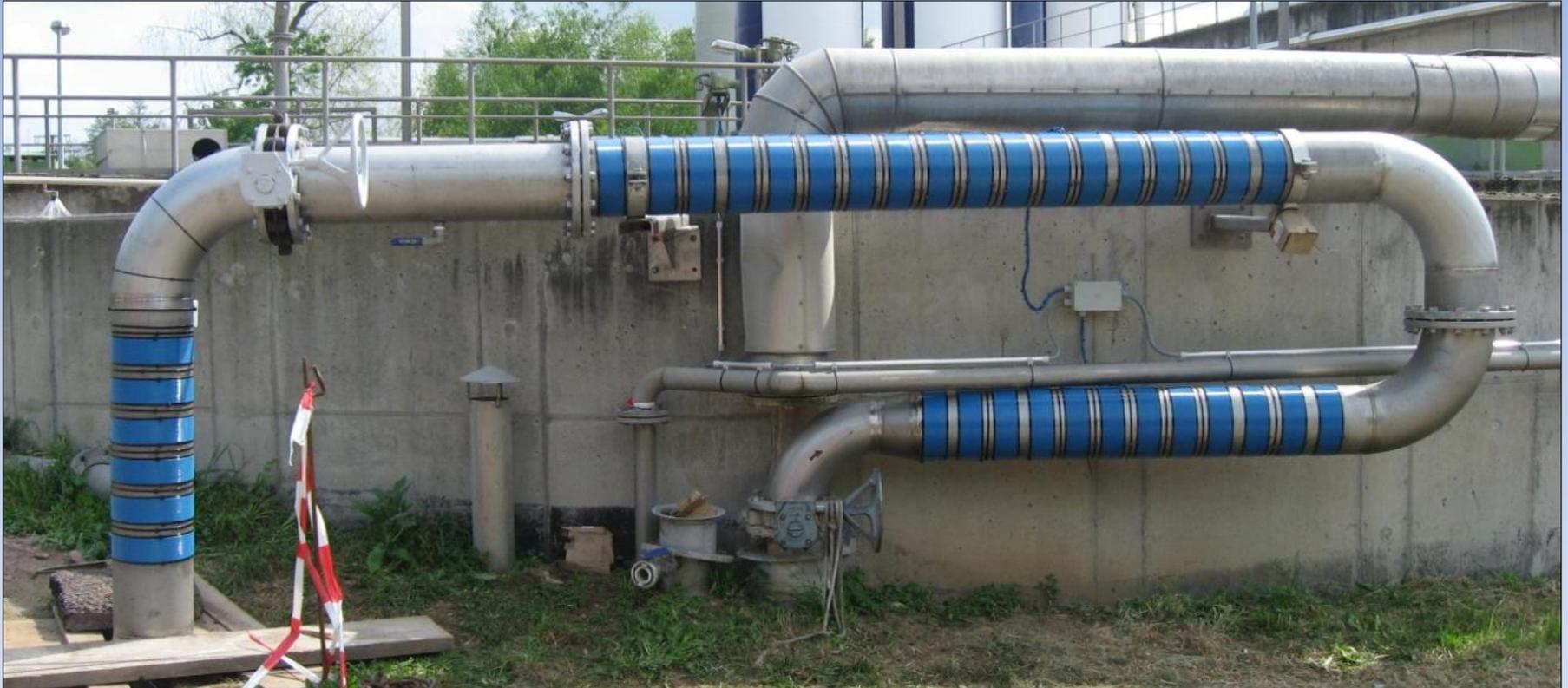
ca. 4.600 m lange Ablauf- / Transferleitungen (DN 250/400 /  $Q_{\max} = 600 \text{ m}^3/\text{h}$ )
